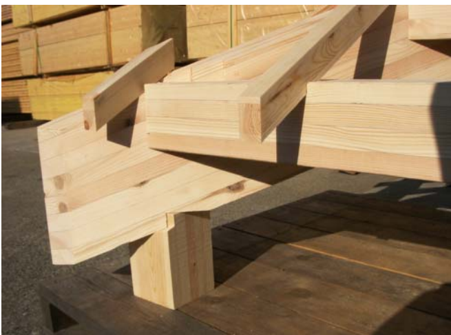
柱に直接登り隅木をのせ、隅木に小屋桁をのせます。（隅木のケラバ落とし出来ます）
